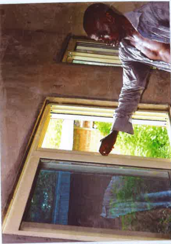
Abb. 10: Die eingebauten Fenster haben Rahmen aus Aluminium mit einem Moskitonetz.
